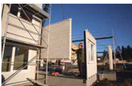
Bruk av ferdigelementer for gulv, tak og vegg.
